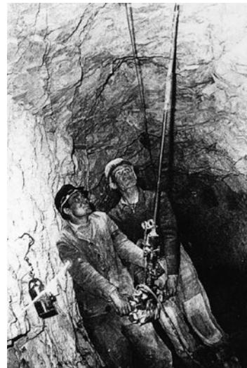
SLIKA 4. Istražno bušenje u podzemlju
