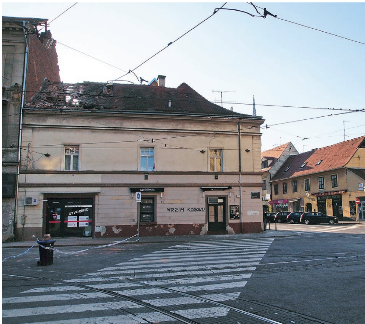
Zgrade oštećene u potresu i grafit „Mrzim koronu“, ugao Draškovićeve i Vlačke, 22. ožujka 2020.
