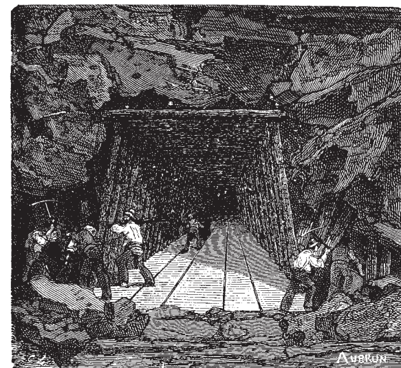
Sl. 156. Tunel, privremeno poduprt stupovi i gredami.
