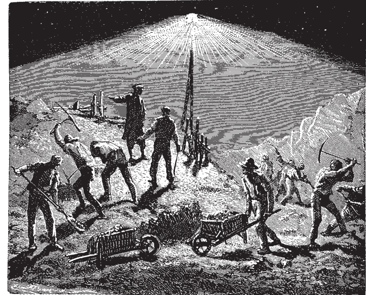
Sl. 109. Radnja po noći pri električnom svjetlu.
