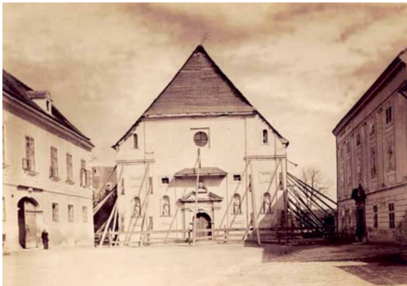
Katarinski trg nakon potresa 9. XI. 1880. Desno zgrada Sveučilišta (danas Gornjogradska gimnazija), sjedište MH od 1878. do 1882. U sredini, potresom teško oštećena crkva Sv. Katarine, bez gornjeg dijela pročelja i s popucanim zidovima.
