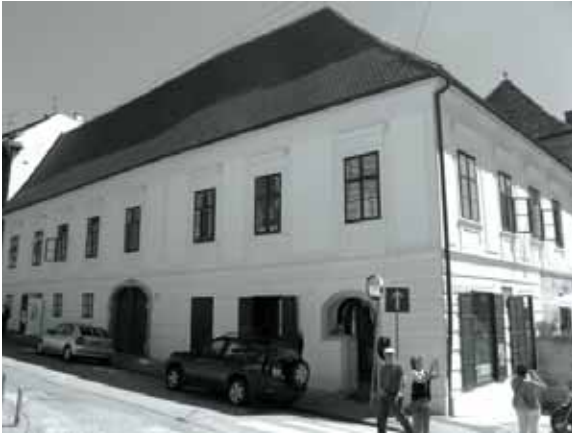
Opatička 2. Kuća je građena postupno i predstavlja jednokatni kompleks koji se pročeljima proteže od Opatičke i Kamenite do Radićeve ulice.
