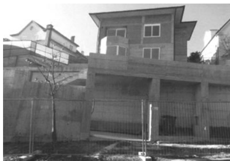
SLIKA 22. Novi potporni zid prema Bosanskoj ulici (2016.); Snimio Zvonko Pađan FIGURE 22. The new retaining wall to Bosanska Street (2016); Photo: Zvonko Pađan
