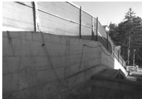
SLIKA 20. Južni ogradni zid nove kuće u Bosanskoj 31 (2016.), Snimio Zvonko Pađan FIGURE 20. South boundary wall of a new house in Bosanska 31 (2016), Photo: Zvonko Pađan
