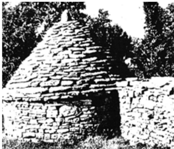
SLIKA 7. Suhozidni kupolasti kružni “ćemer” FIGURE 7. Dry wall dome-shaped circular “ćemer”
