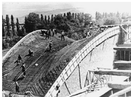
SLIKA 8. Gradnja Velike predavaonice za kemiju, krovna konstrukcija
