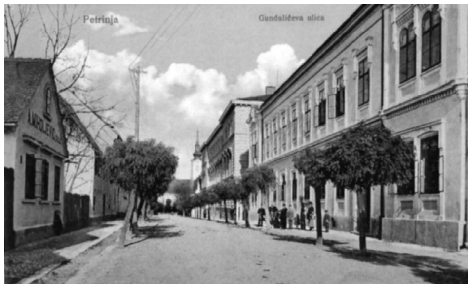
SLIKA 1. Prva osnovna škola u Petrinji FIGURE 1. The first primary school in Petrinja
