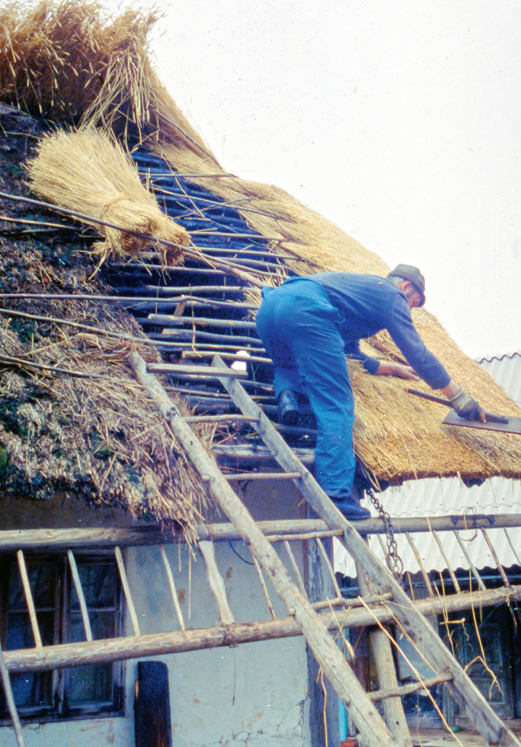
Postavljanje nove škope na krov, snimljeno 1985.
