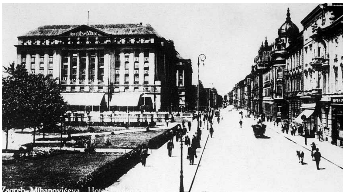
Hotel »Esplanade« izgrađen 1925. prema nacrtu Dioniza Sunka
